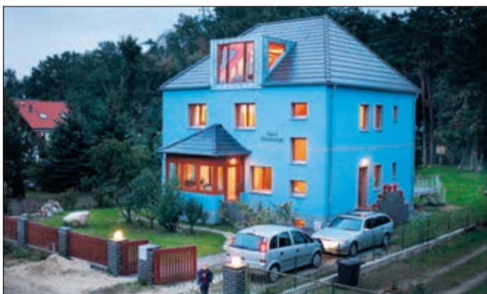
Ziel erreicht – alte Bausubstanz wurde erhalten und zu Wohneigentum mit modernem Komfort und hohen energetischen Standards umgebaut und modernisiert. Bild: Bauherren Schutzbund
